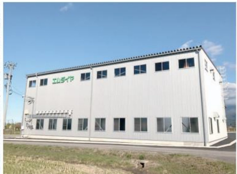
竣工した「コトづくり」拠点
